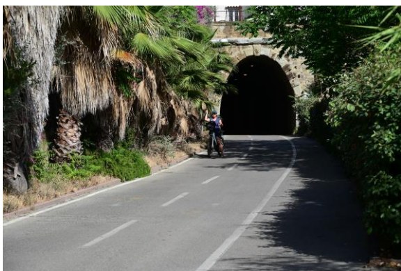
Radweg durch einen früheren Eisenbahntunnel
